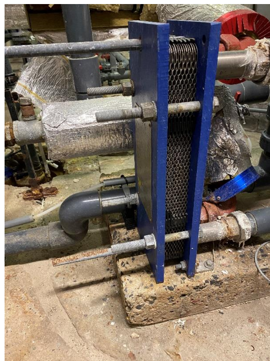
Échangeur de chaleur qu'il faudrait isoler aussi.
